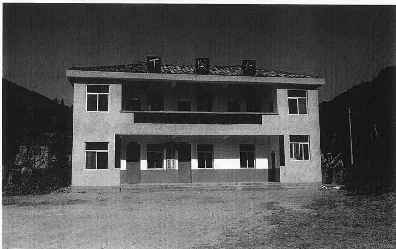
下版寮村委会新址 建于二〇〇八年
