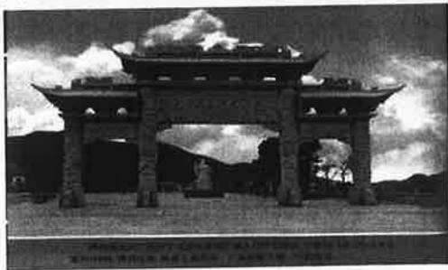
新建的總祠牌樓
