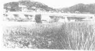
雁塔济美大桥
